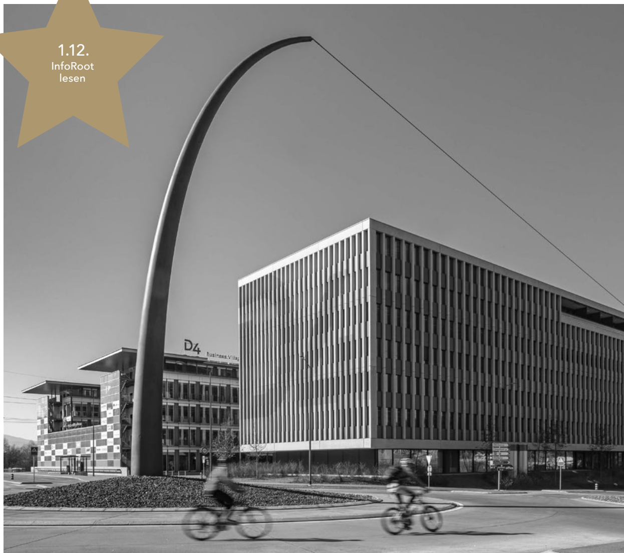
Hauptgebäude Square One
