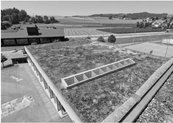
Nahaufnahme vom Dach der Turnhalle
